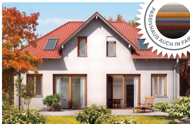
und stilvolle Altbau-Sanierung.
